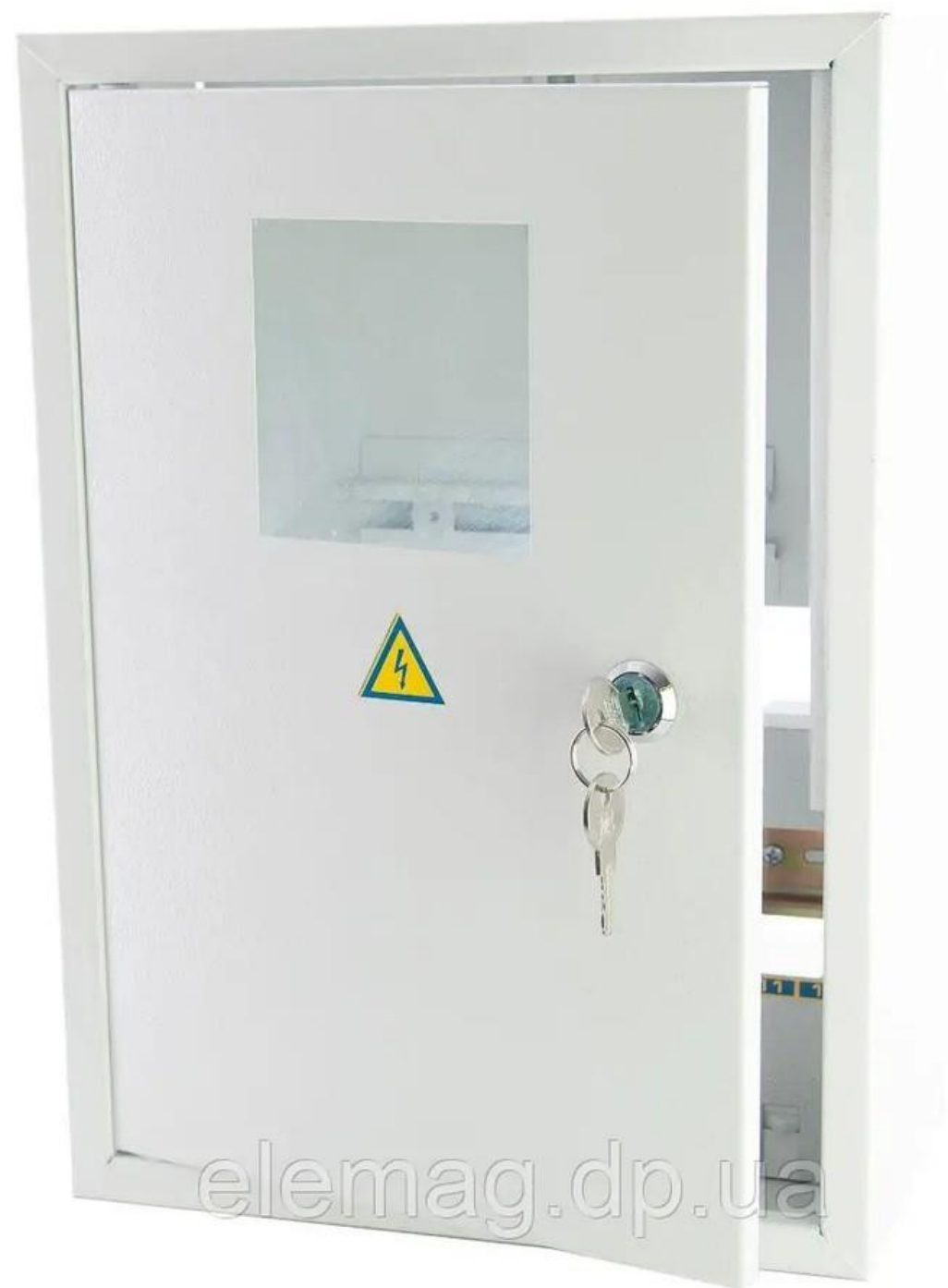
Замінено електричні щитки
